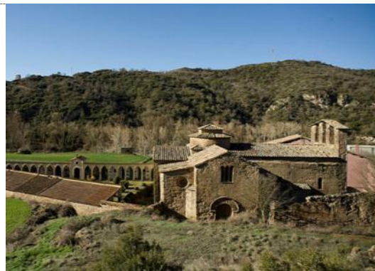
Vista del monestir des de l'exterior (nord-est)
