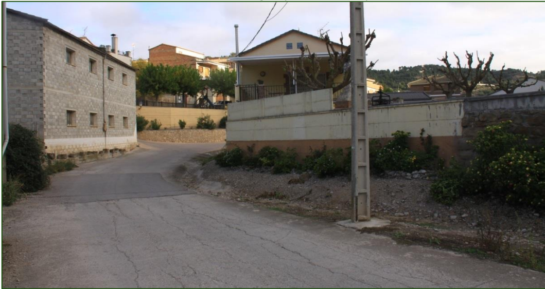
Il·lustració 59: Zona de llera del Torrent de Magrà que transcorre pel carrer.
