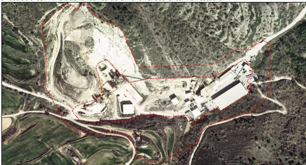
Il·lustració 65: Àmbit de la fàbrica de ciment i el seu entorn a restaurar
