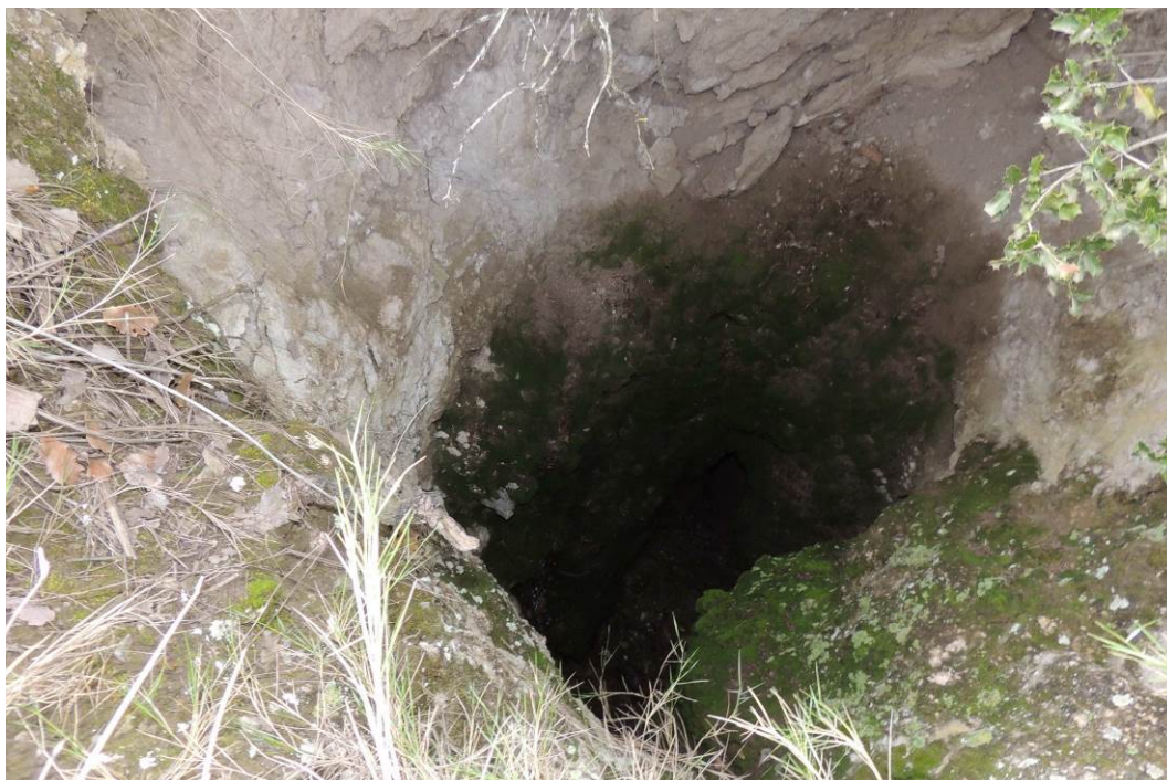
Fotografia 4. Detall d'esfondrament en materials detrítics quaternaris.
