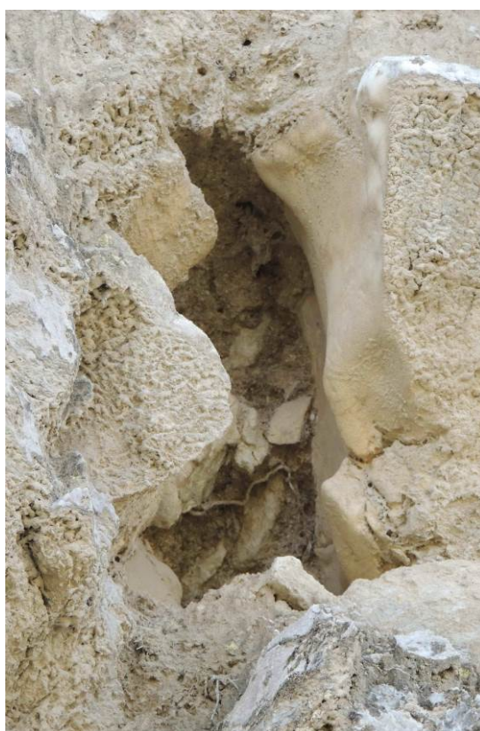
Fotografia 7. Detall de carstificació de guixos al camí de Castellfollit de Riubregós a Ferran.
