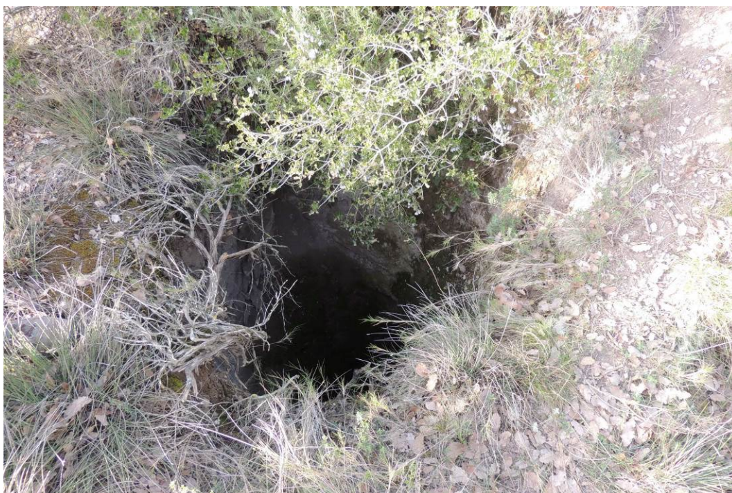
Fotografia 5. Detall d'esfondrament en materials detrítics quaternaris.
